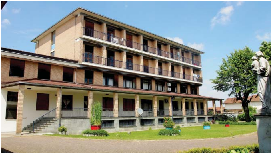
Verwaltungsgebäude in Carmagnola seit 1966
