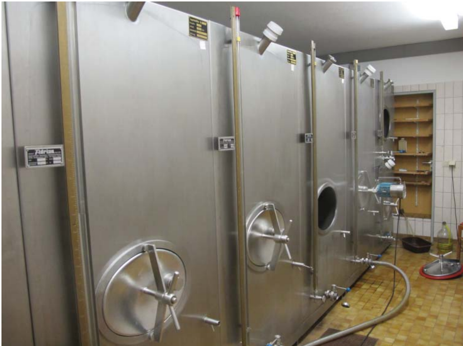
Edelstahltanks zur Lagerung von Arquebuse und Hermite im Keller
